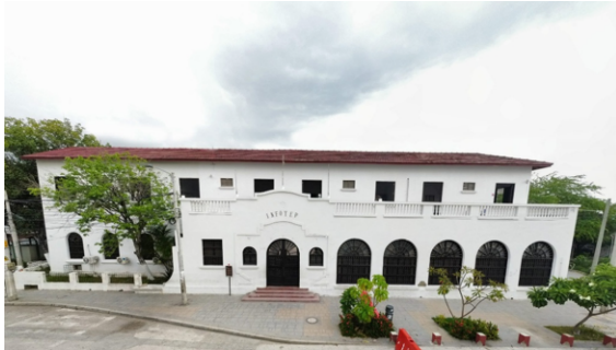
Imagen 1. Fachada sede plaza del Centenario
