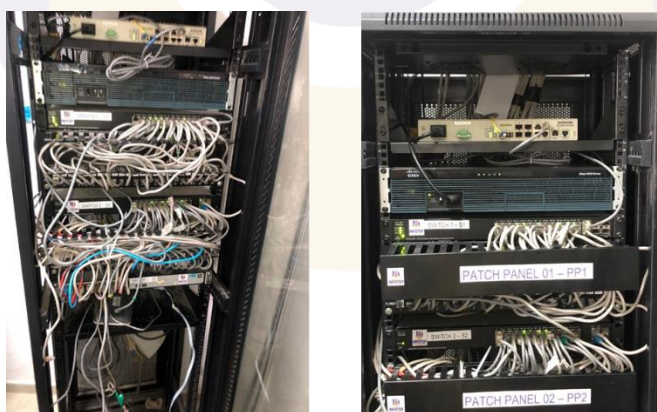
Imagen 22. Rack principal después del mantenimiento preventivo
