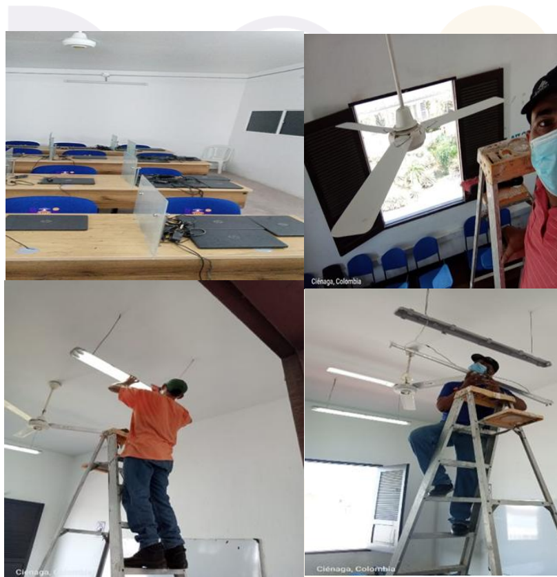
Imagen 21. Actividades Programa de Infraestructura
